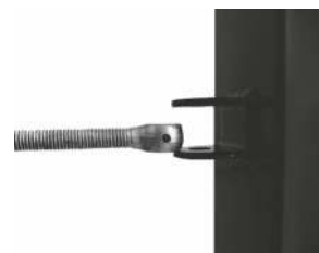
Откидной болт петли
